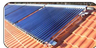
Vakuurrörssolfångare på tegeltak
